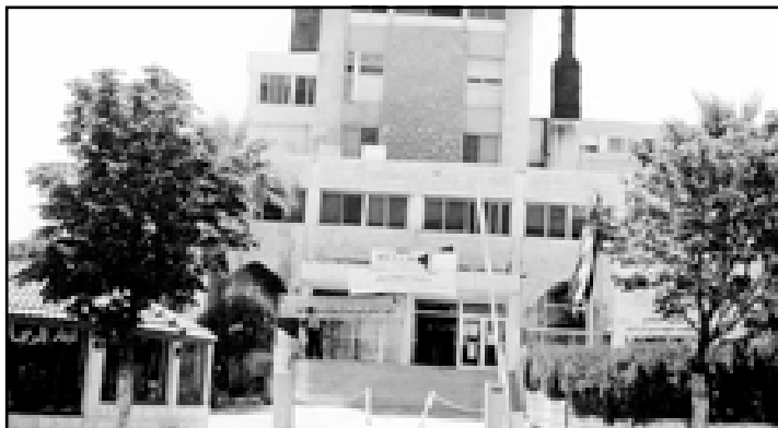
مبنى مجمع النقابات المهنية في عمان
